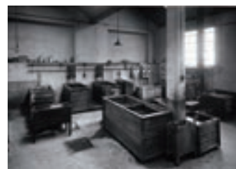
1950 Departamento de galvanização
